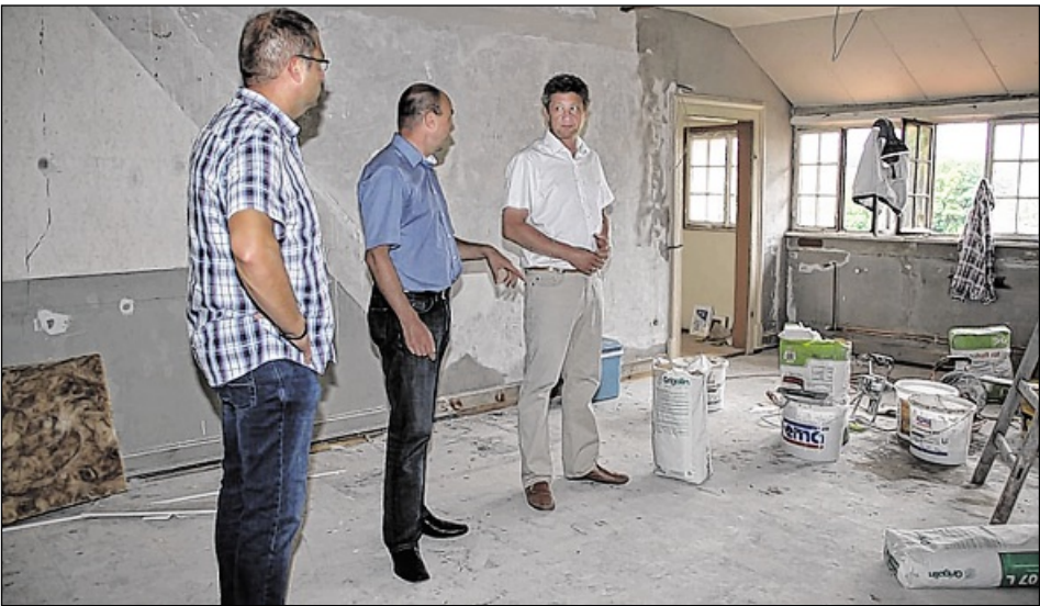
BAUSTELLENBEGEHUNG: Bürgermeister Ulrich Hintermayer überzeugt sich vom Baufortschritt im 2. OG des Graf-Eberstein-Schlosses. Foto: Frei
